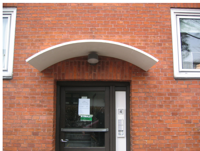
BELYSNINGSAMATUR BALDARKIN DØRTELEFON OG LÅSE
